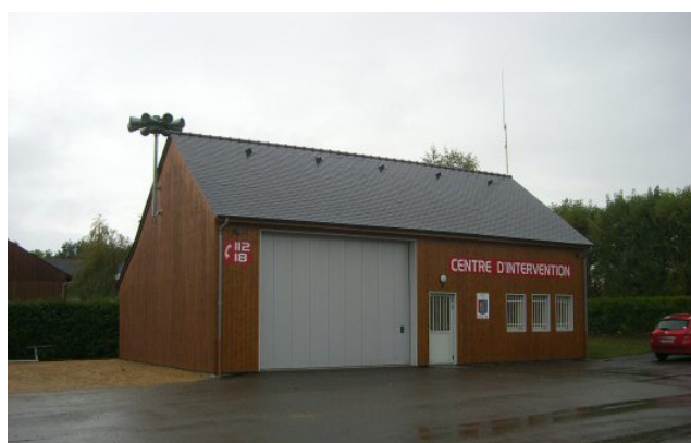
Le centre d'incendie et de secours de Mouliherne
